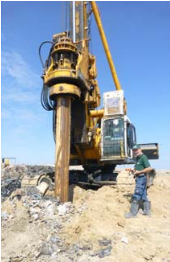
Kontrolle von GB – Bohrungen in Rußland
